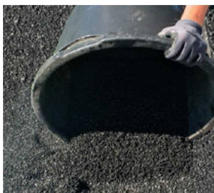
aplicare split adăugat prin amestecare pe stratul portant
