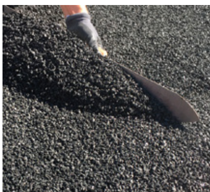
distribuire, compactare, netezire
