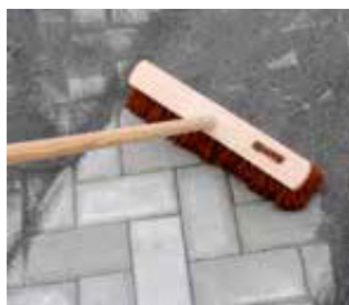
rostituire și îndepărtare surplus material
